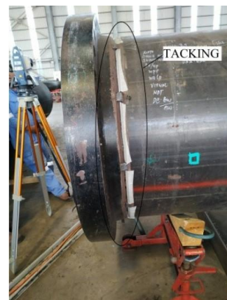
Gambar 2: Proses Fit up dan Tack weld
