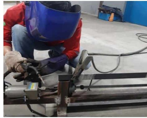
Gambar 14: Pemasangan Motor Penggerak
