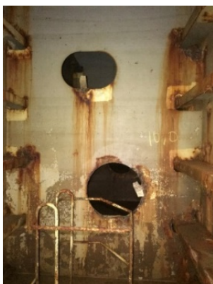
Gambar 8: Korosi pada Forepeak Tank
