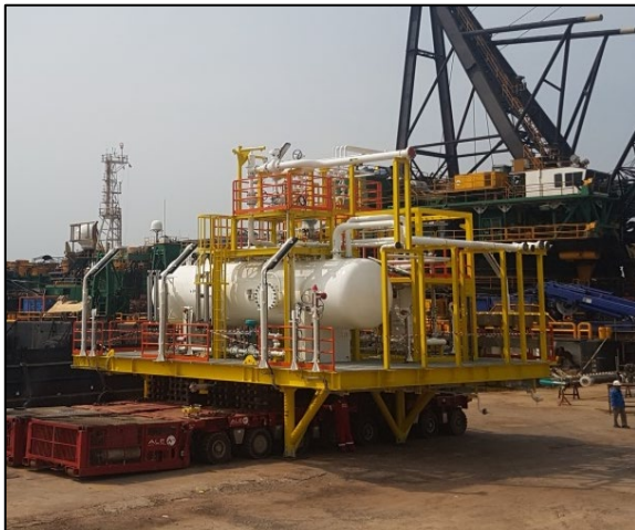
Gambar 1: Konstruksi FPSO module water separation
