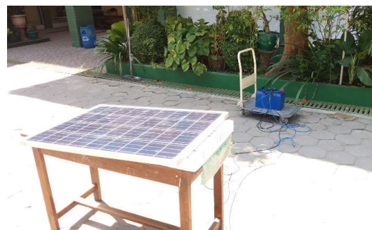
(a) Pengujian fungsi perangkat panel surya
