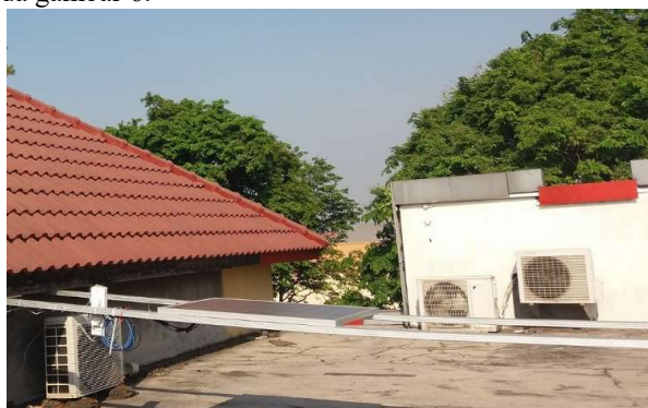
(a) Simulasi panel surya dan access point di lingkungan nyata
