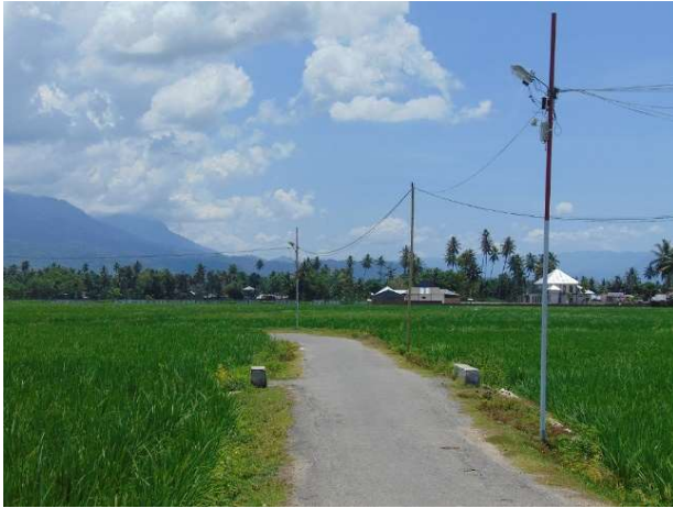
Gambar 3. Implementasi jaringan internet yang menggunakan model penyambungan kabel antar tiang. Sumber: [1]
