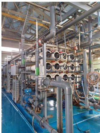
Gambar 1. Tampak Depan Peralatan SWRO
