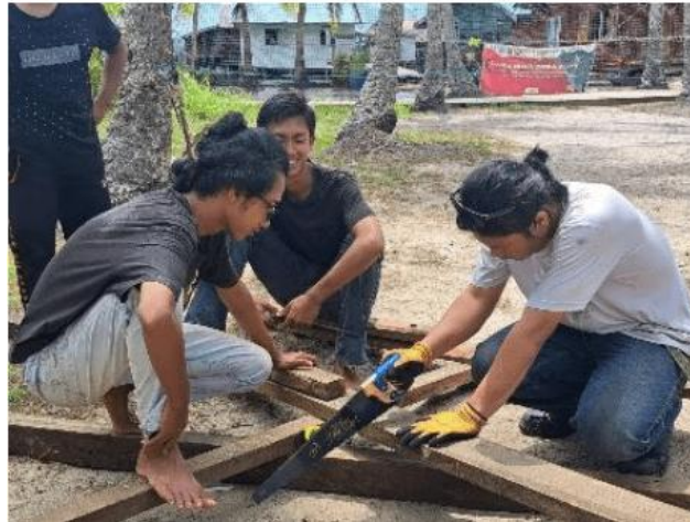
Gambar 10: Pembuatan dudukan Tandon Air
