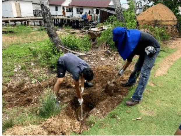
Gambar 6. Penggalian Tanah untuk Pondasi Tiang Penopang Lampu Jalan
