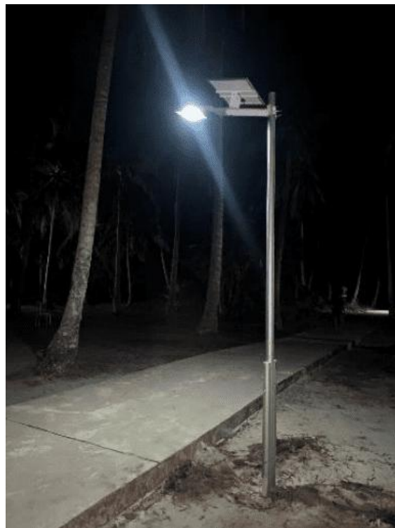
Gambar 9: Lampu Jalan Tenaga Surya Telah Berfungsi di Pulau Jemare
