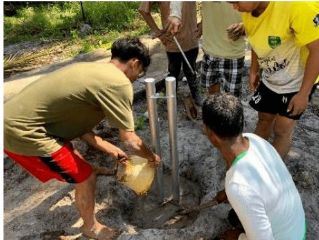
Gambar 7. Pemasangan Pondasi Lampu Jalan Tenaga Surya
