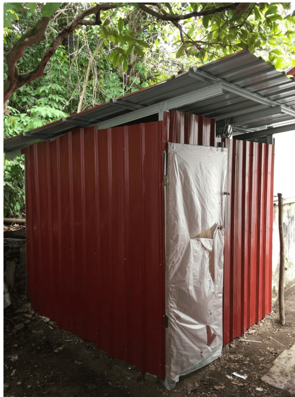
Gambar 5. Rumah Diesel Siap Digunakan
