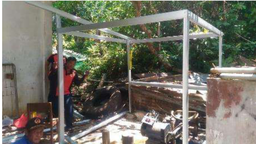
Gambar 4. Progres Pembangunan Rumah Diesel
