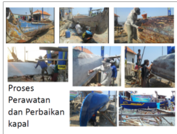
Gambar 6 Proses Reparasi Kapal
